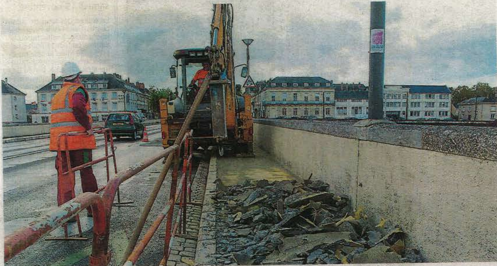
Saumur, pont des Cadets, mardi. Le marteau-piqueur a défoncé le trottoir afin d'accéder aux câbles souterrains enterrés dans le pont.
