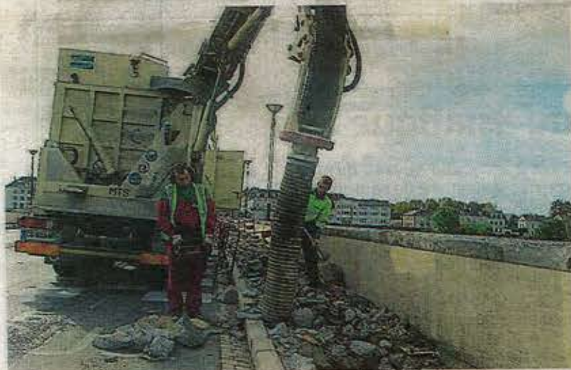
L'aspirateur est piloté à l'aide d'une manette par un technicien.
